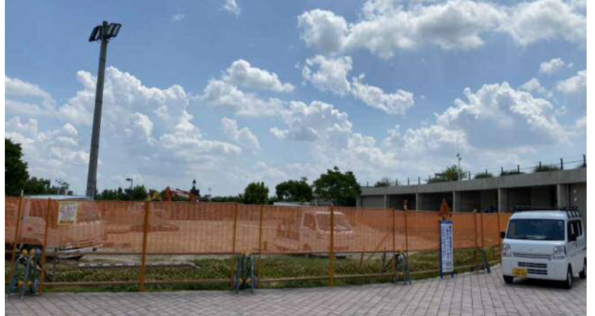
イベント広場(現在工事中)
